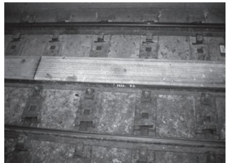
鉄輪式リニア路線でレールの間に設置されるリアクションプレート
